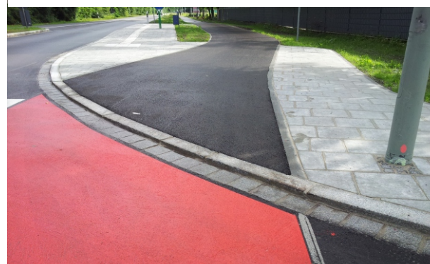
Situation nach Fertigstellung 2017 (Radweg Freisinger Straße)
