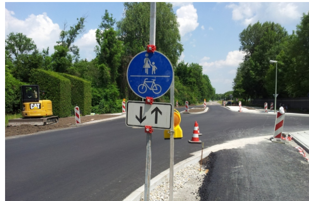
Realisierungsphase (Umbau Radweg und Knotenpunkt)
